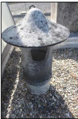
Photo N° 189 ECH-4 AMIANTE CIMENT -1 rue Curie-Toiture_1 rue Curie Conduits de fluide Chapeau+conduit de ventilation haute de la GT Gaz (Fibres-ciment)
