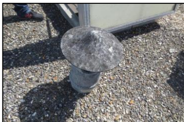
Photo N° 242 ECH-21 AMIANTE CIMENT -5 rue Curie-Toiture_5 rue Curie Conduits de fluide Chapeau+conduit de ventilation haute de la GT Gaz (Fibres-ciment)
