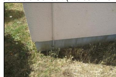
Photo N° 292 ECH-46 AMIANTE CIMENT -3 rue Calmette-Vide Sanitaire_3 rue Calmette Fourreau de câble Conduit (Fibres-ciment)
