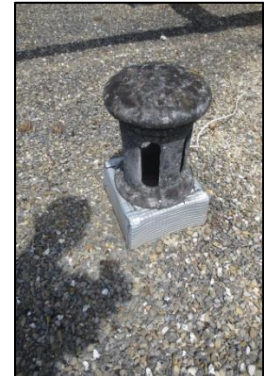
Photo N° 282 ECH-40 AMIANTE CIMENT -3 rue Calmette-Toiture_3 rue Calmette Conduits de fluide Chapeau+conduit de ventilation haute de la GT Gaz (Fibres-ciment)
