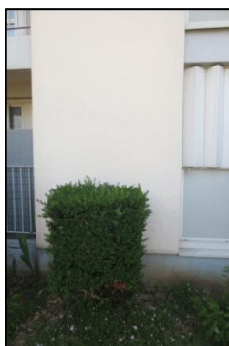
Photo N° 233 ECH-16 -3 rue Curie-Façade_3 rue Curie Murs Béton+Crépi
