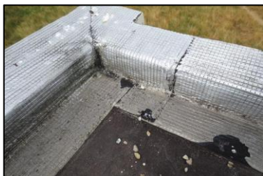
Photo N° 351 ECH-67 -9 rue Calmette-Toiture_9 rue Calmette Bardeaux Etanchéité type "paxalu"
