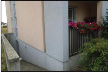
Photo N° 365 ECH-72 -9 rue Calmette-Façade_9 rue Calmette Murs Béton+Crépi bleue
