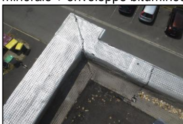
Photo N° 256 ECH-28 -1 rue Calmette-Toiture_1 rue Calmette Bardeaux Etanchéité type "paxalu"
