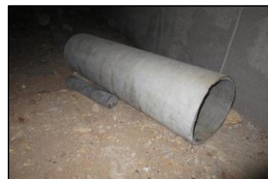
Photo N° 292 ECH-46 AMIANTE CIMENT -3 rue Calmette-Vide Sanitaire_3 rue Calmette Fourreau de câble Conduit (Fibres-ciment)
