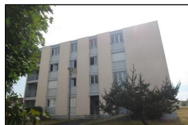
Photo N° 346 ECH-62 -7 rue Calmette-Façade_7 rue Calmette Murs Béton+Crépi rose
