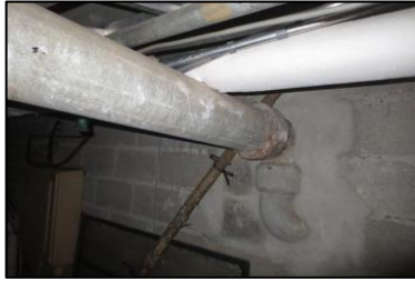
Photo N° 181 AMIANTE CIMENT - 1 rue Curie-Local_1 rue Curie Conduits de fluide Chute E.U. (Fibres-ciment)
