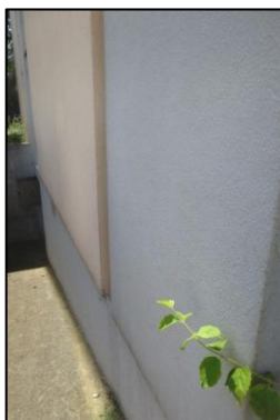
Photo N° 247 ECH-23 -5 rue Curie-Façade_5 rue Curie Murs Béton+Crépi rose
