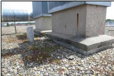
Photo N° 270 ECH-35 -1 rue Calmette-Façade_1 rue Calmette Murs de Soubassement Béton+Crépi
