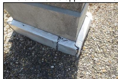
Photo N° 219 ECH-12 -3 rue Curie-Toiture_3 rue Curie Souches Cheminée Etanchéité type "paxalu"
