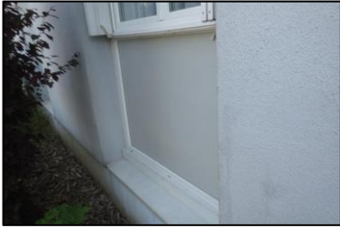
Photo N° 1201 Intérieur des allèges des Façades non visité, coffre métallique empêchant l'accès.
