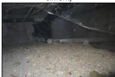
Photo N° 343 ECH-46 AMIANTE CIMENT -7 rue Calmette-Vide Sanitaire_7 rue Calmette Fourreau de cable Conduit (Fibres-ciment)
