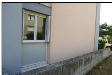
Photo N° 289 ECH-43 -3 rue Calmette-Façade_3 rue Calmette Murs Béton+Crépi rose
