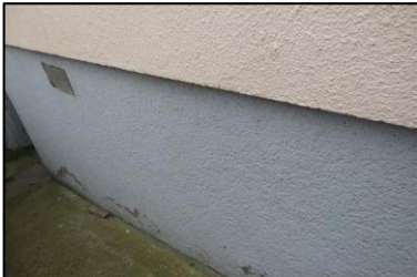
Photo N° 264 ECH-32 -1 rue Calmette-Toiture_1 rue Calmette Autour Conduit Mastic Gris
