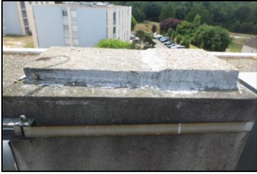
ventilation haute de la GT Gaz (Fibres-ciment)
