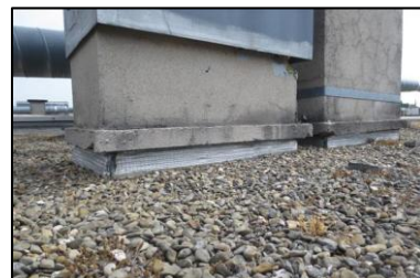
Photo N° 353 ECH-68 -9 rue Calmette-Toiture_9 rue Calmette Souches Cheminée Etanchéité type "paxalu"
