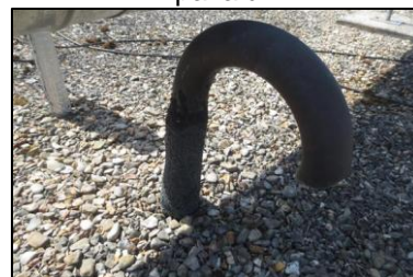
Photo N° 222 ECH-14 -3 rue Curie-Toiture_3 rue Curie Autour Fourreau Revêtement bitumineux
