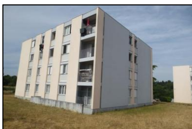
Photo N° 344 ECH-63 -7 rue Calmette-Façade_7 rue Calmette Murs Béton+Crépi bleue
