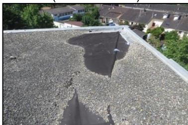
Photo N° 238 ECH-18 -5 rue Curie-Toiture_5 rue Curie Planchers Revêtement bitume + mousse
