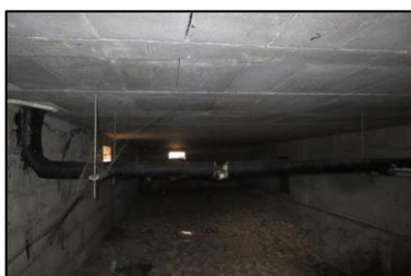
Photo N° 340 ECH-65 CALORIFUGEAGE Gaines & coffres horizontaux Laine minérale + enveloppe bituminée
