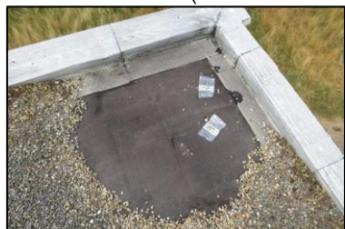
Photo N° 349 ECH-66 -9 rue Calmette-Toiture_9 rue Calmette Planchers Revêtement bitume + mousse
