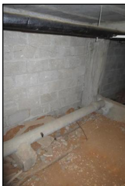
Photo N° 224 AMIANTE CIMENT - 3 rue Curie-Vide Sanitaire_1 rue Curie Fourreau de câble Conduit (Fibres-ciment)
