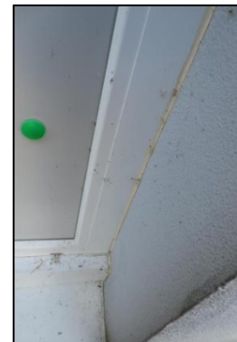
Photo N° 200 Intérieur des allèges des Façades non visité, coffre métallique empêchant l'accès.
