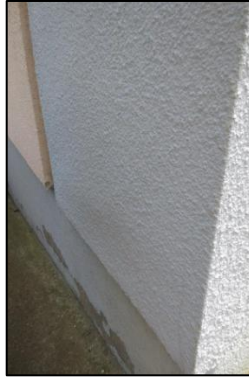
Photo N° 268 ECH-34 -1 rue Calmette-Façade_1 rue Calmette Murs Béton+Crépi bleue
