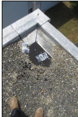
Photo N° 276 ECH-37 -3 rue Calmette-Toiture_3 rue Calmette Planchers Revêtement bitume + mousse
