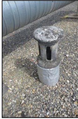
Photo N° 356 ECH-69 AMIANTE CIMENT -9 rue Calmette-Toiture_9 rue Calmette Conduits de fluide Chapeau+conduit de ventilation haute de la GT Gaz (Fibres-ciment)
