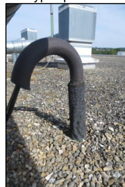
Photo N° 321 ECH-51 -5 rue Calmette-Toiture_5 rue Calmette Autour Fourreau Revêtement bitumineux
