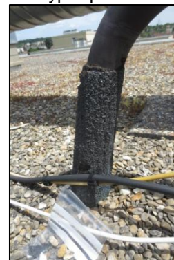
Photo N° 263 ECH-31 -1 rue Calmette-Toiture_1 rue Calmette Autour Fourreau Revêtement bitumineux
