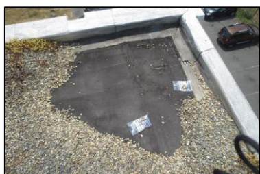
Photo N° 255 ECH-27 -1 rue Calmette-Toiture_1 rue Calmette Planchers Revêtement bitume + mousse
