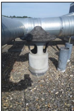
Photo N° 320 ECH-50 AMIANTE CIMENT -5 rue Calmette-Toiture_5 rue Calmette Conduits de fluide Chapeau+conduit de ventilation haute de la GT Gaz (Fibres-ciment)
