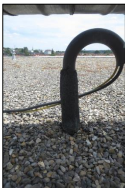
Photo N° 283 ECH-41 -3 rue Calmette-Toiture_3 rue Calmette Autour Fourreau Revêtement bitumineux
