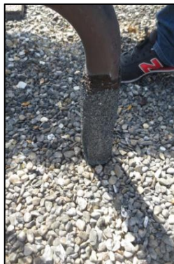
Photo N° 199 ECH-5 -1 rue Curie-Toiture_1 rue Curie Autour Fourreau Revêtement bitumineux
