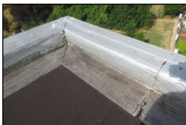
Photo N° 316 ECH-48 -5 rue Calmette-Toiture_5 rue Calmette Bardeaux Etanchéité type "paxalu"
