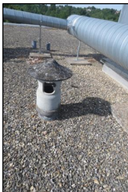
Photo N° 319 ECH-50 AMIANTE CIMENT -5 rue Calmette-Toiture_5 rue Calmette Conduits de fluide Chapeau+conduit de ventilation haute de la GT Gaz (Fibres-ciment)
