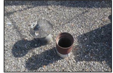
Photo N° 185 ECH-4 AMIANTE CIMENT -1 rue Curie-Toiture_1 rue Curie Conduits de fluide Chapeau+conduit de ventilation haute de la GT Gaz (Fibres-ciment)
