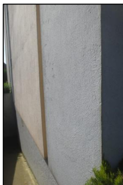
Photo N° 202 ECH-6 -1 rue Curie- Façade_1 rue Curie Murs Béton+Crépi rose
