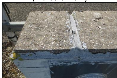
Photo N° 319 ECH-50 AMIANTE CIMENT -5 rue Calmette-Toiture_5 rue Calmette Conduits de fluide Chapeau+conduit de ventilation haute de la GT Gaz (Fibres-ciment)
