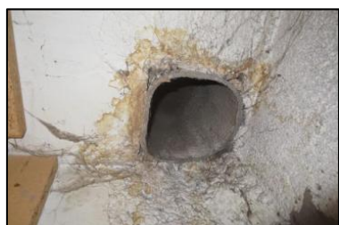
Photo N° 337 ECH-60 AMIANTE CIMENT -7 rue Calmette-Toiture_7 rue Calmette Conduits de fluide Conduit de ventilation haute de la GT Gaz (Fibres-ciment)
