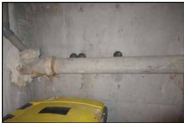
Photo N° 358 ECH-61 -7 rue Calmette-Toiture_7 rue Calmette Autour Fourreau Revêtement bitumineux
