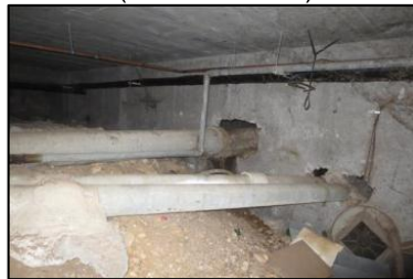
Photo N° 356 ECH-69 AMIANTE CIMENT -9 rue Calmette-Toiture_9 rue Calmette Conduits de fluide Chapeau+conduit de ventilation haute de la GT Gaz (Fibres-ciment)
