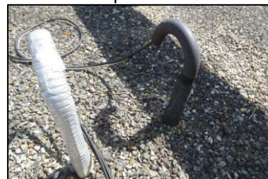
Photo N° 244 ECH-22 -5 rue Curie-Toiture_5 rue Curie Autour Fourreau Revêtement bitumineux
