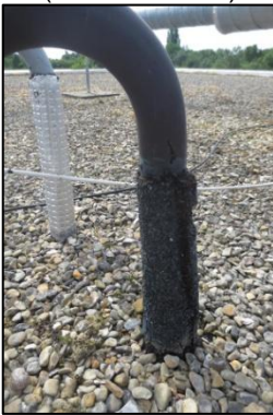
Photo N° 358 ECH-61 -7 rue Calmette-Toiture_7 rue Calmette Autour Fourreau Revêtement bitumineux
