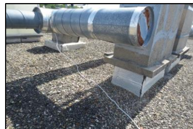
Photo N° 241 ECH-20 -5 rue Curie-Toiture_5 rue Curie Souches Cheminée Etanchéité type "paxalu"
