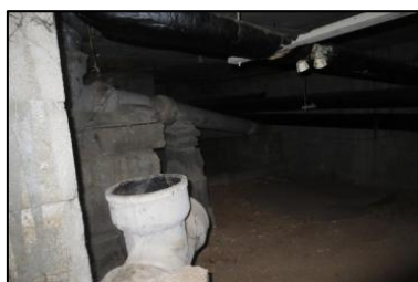
Photo N° 224 AMIANTE CIMENT - 3 rue Curie-Vide Sanitaire_1 rue Curie Fourreau de câble Conduit (Fibres-ciment)
