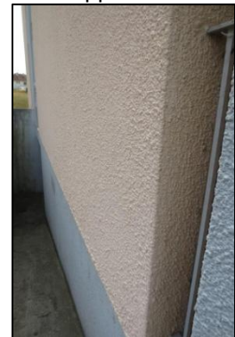
Photo N° 364 ECH-71 -9 rue Calmette-Façade_9 rue Calmette Murs Béton+Crépi rose
