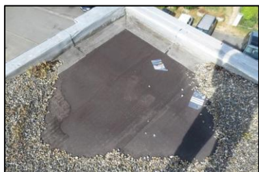
Photo N° 314 ECH-47 -5 rue Calmette-Toiture_5 rue Calmette Planchers Revêtement bitume + mousse
