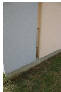
Photo N° 288 ECH-42 -3 rue Calmette-Façade_3 rue Calmette Murs Béton+Crépi bleu
